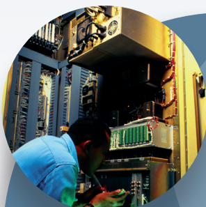
Оборудование для преобразования энергии
